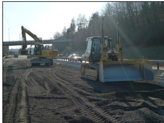
Dozer mit Maschinenleitsystem
