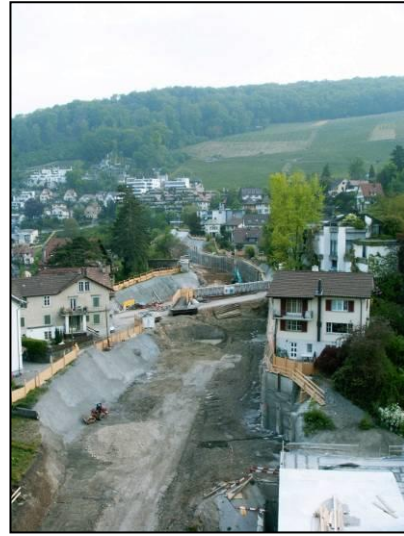
Überblick über die Baustelle
