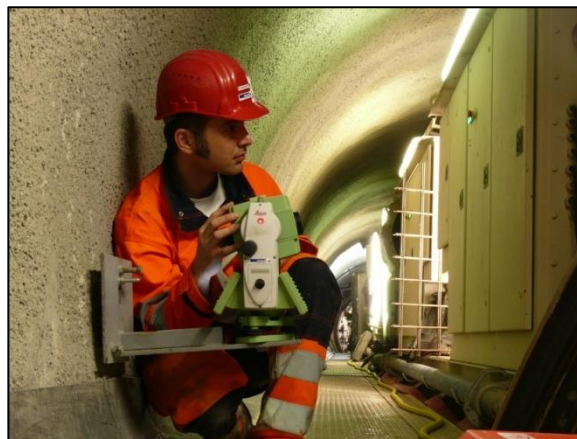
Profillkontrolle inmitten der Tunnelbohrmaschine
