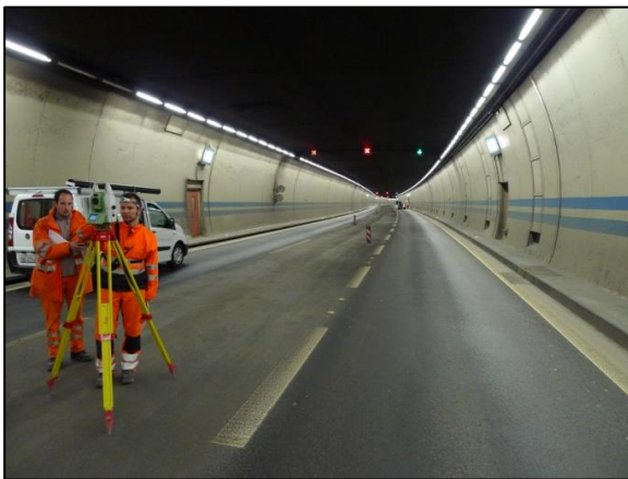
Netzmessung im Strassentunnel
