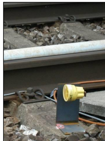
Überwachungspunkt (Reflektor) auf Bahnschwelle
