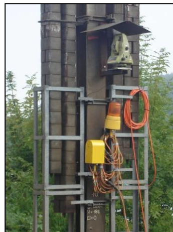
Tachymeter an Fahrleitungsmast
